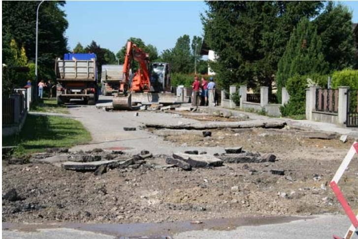
Fa. Schmalek GmbH hat mit dem Abbruch der Betonplatten die "Baustelle – Sportplatzstraße" begonnen. Diese Betonplatten wurden auf LKW verladen und zum Sonnwendfeuer Platz gebracht und dort zwischen gelagert.
